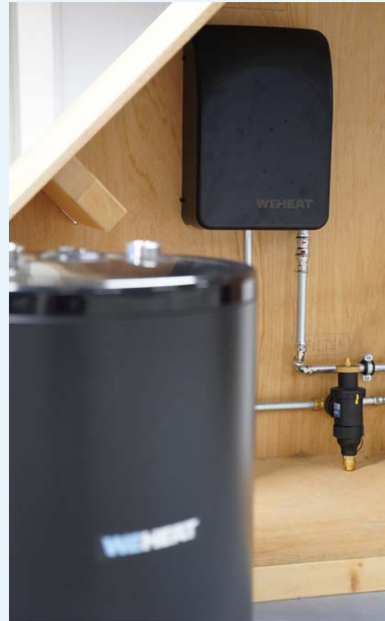
Een bij de Blackbird-warmtepomp behorende binnenunit, met op de voorgrond een Weheat-buffervat.
